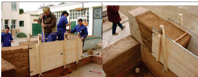
Figura 3. Construcción de tapial y muro de tapia en la Escuela Taller de Almansa (Albacete). Octubre 2003.
