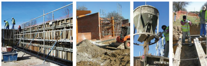
Figura 6. Distintas fases de la ejecución de los muros de tapia (Izq. a drcha. a,b,c,d).
