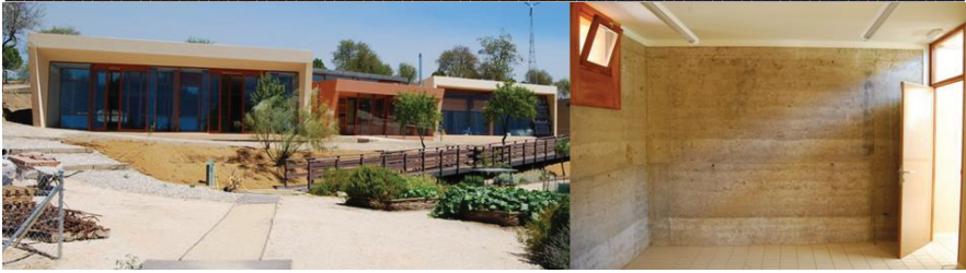
Figura 5. Imagen exterior de los distintos módulos que componen el edificio y muro de la biblioteca con tapia de tierra.
