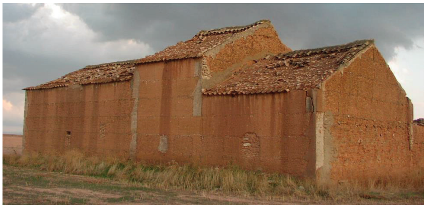
Figura 1. Construcción con muros de tapia de tierra en Montalvos (Albacete).
