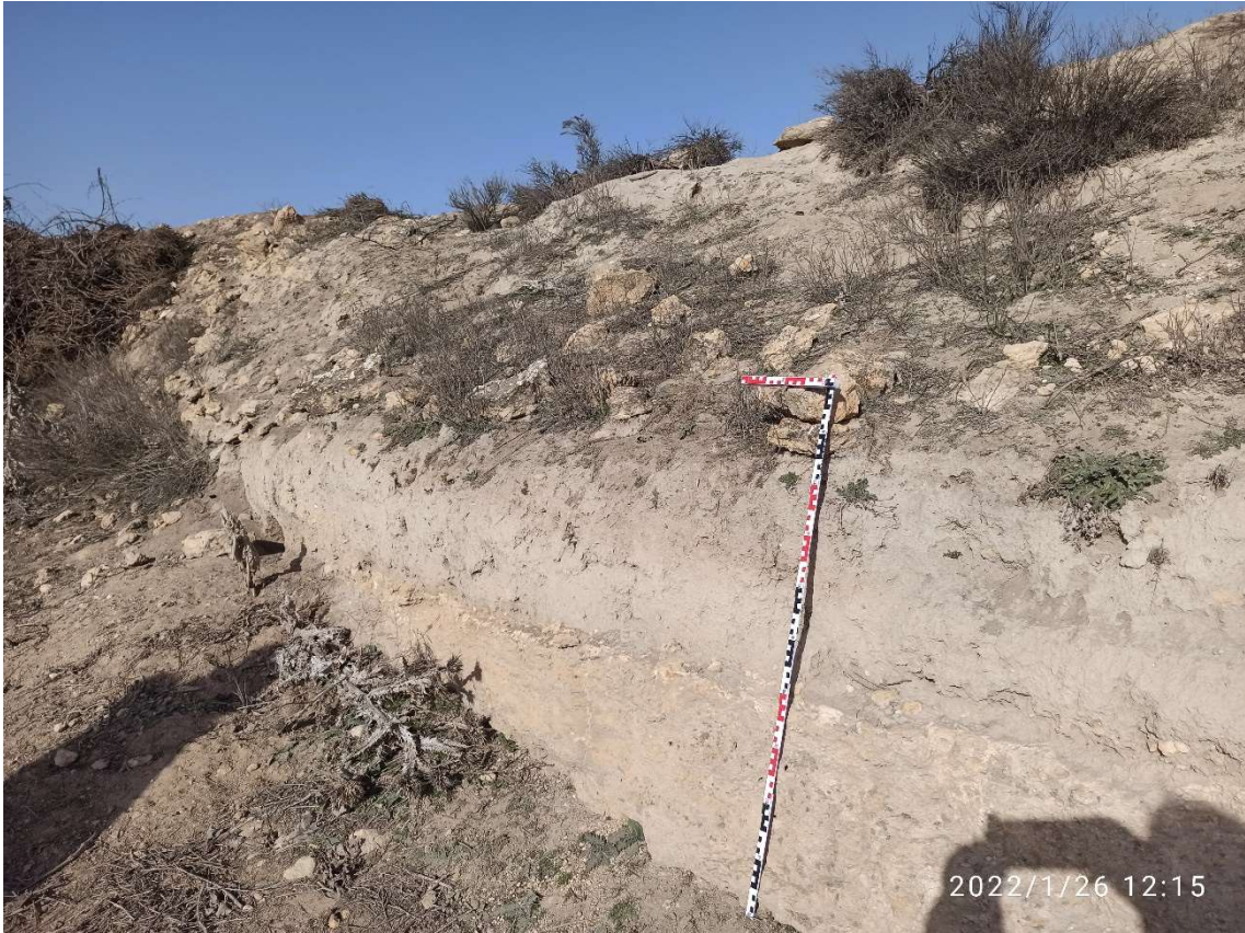
Figura 28: Potencia de los áridos aportados para formar el terraplén al objeto de mantener la cota del canal que se dirige al molino del Cuervo.
