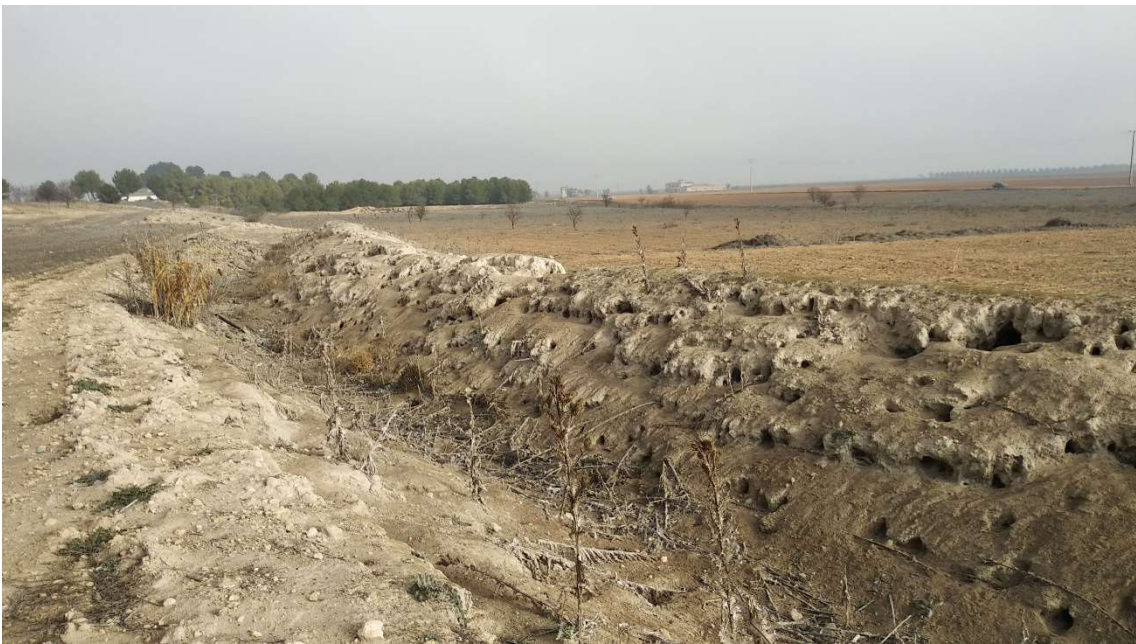
Figura 37: Ídem. Se aprecia en el talud de la margen o malecón derecho los orificios de las madrigueras de conejos.
