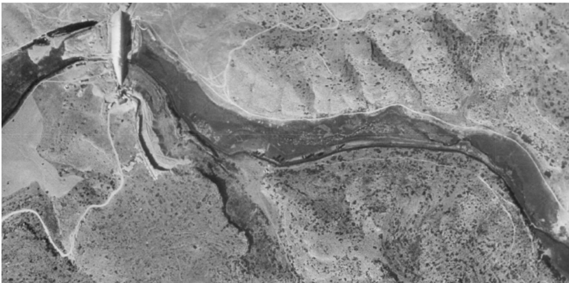
Figura 11: Ortofotografía del Vuelo Americano 1956-1957. Serie B. Presa de Estrecho de Peñarroya, en construcción. Se aprecia aguas arriba (a la derecha en la foto) el canal de Villanueva, que arrancaba desde la presa anterior o del Atajadero. Se aprecia la silueta de algún árbol en el curso del canal.
