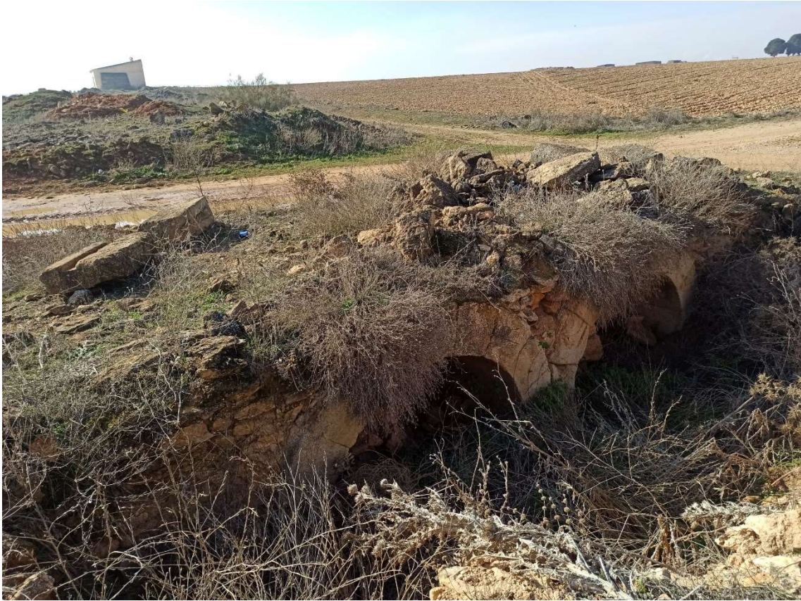
Figura 34: Restos de un puente a pocos metros aguas abajo del Molino del Cuervo. La construcción a un agua del fondo de la foto se ubica junto al molino del Cuervo. La ubicación del puente indica la traza del canal del Gran Prior.
