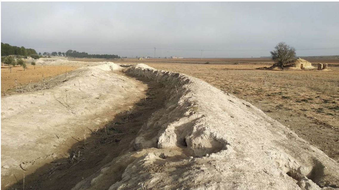
Figura 35: Vestigios del Canal del Gran Prior en el tramo entre molino del Cuervo y la casa del Minguillo, ya en el área de Alameda de Cervera. Se aprecia tanto su sobre elevación sobre el terreno circundante como que los materiales terreros empleados en su construcción son fruto del acarreo de áridos no existentes en las inmediaciones.
