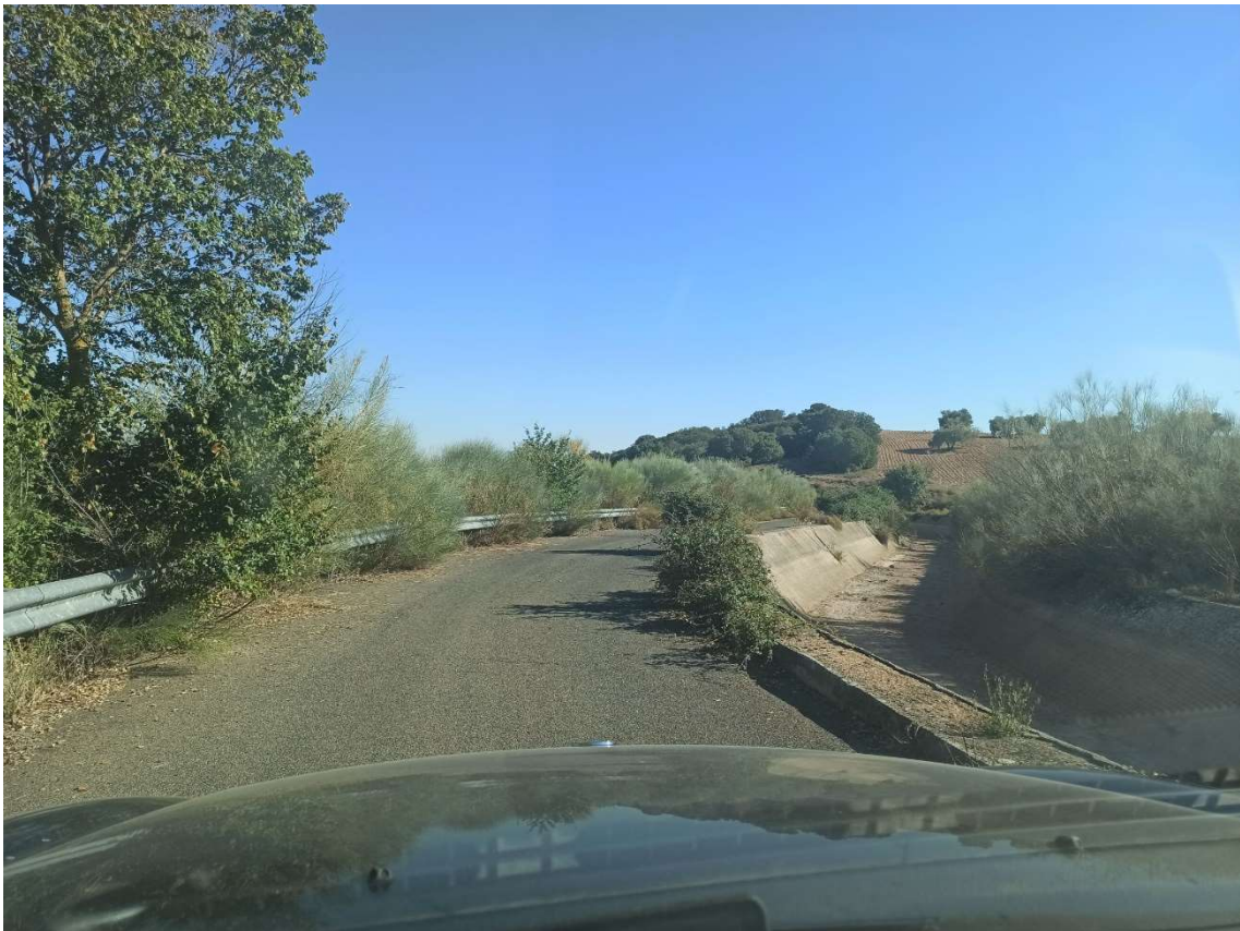
Figura 15: Canal diseñado después de la puesta en funcionamiento de la presa de Peñarroya, en su tramo hacia el Molino de Santa María.
