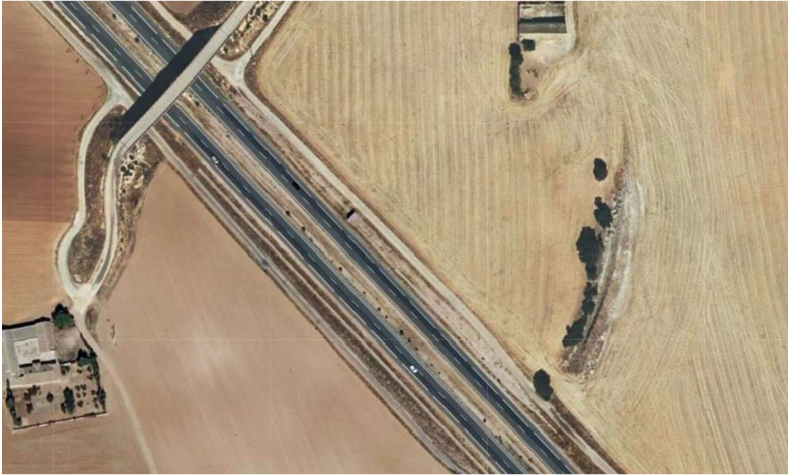
Figura 53: Ortofotografía actual que muestra el tramo conservado.
