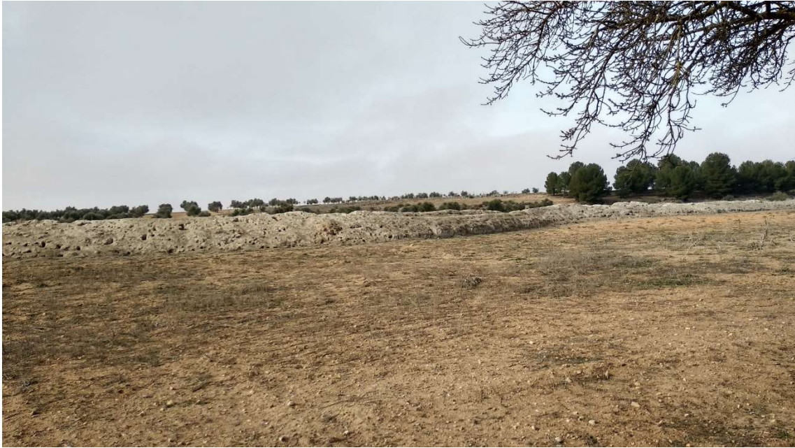
Figura 42: Ídem. Se aprecia la sobreelevación del terraplén del canal sobre el terreno circundante.
