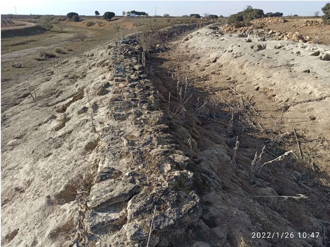
Figura 44: Ídem. Se observa cómo está reforzado con mampostería el muro o malecón derecho del canal (en el sentido de las aguas). En la parte alta de la fotografía, en la izquierda de la misma, se observa el actual cauce del nominado como río Guadiana, que no es sino el canal de avenamiento del embalse de Peñarroya. Ubicado a cota inferior a la del canal, es un cauce artificial inexistente antes de la construcción de dicho embalse. Antes de su construcción, y al margen de eventos de inundación, ningún río, o corriente natural de agua, ha llegado en tiempos históricos a la población de Alameda de Cervera.
