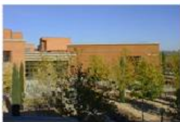
EDIFICIO ENRIQUE COSTA NOVELLA Ingeniería Química
